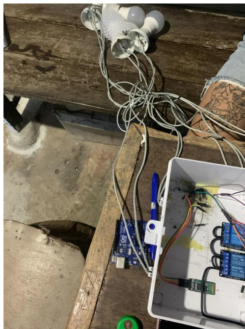
รูปที่ ก.6 ทำการต่อหลอดไฟเข้าแต่ละ Connector
